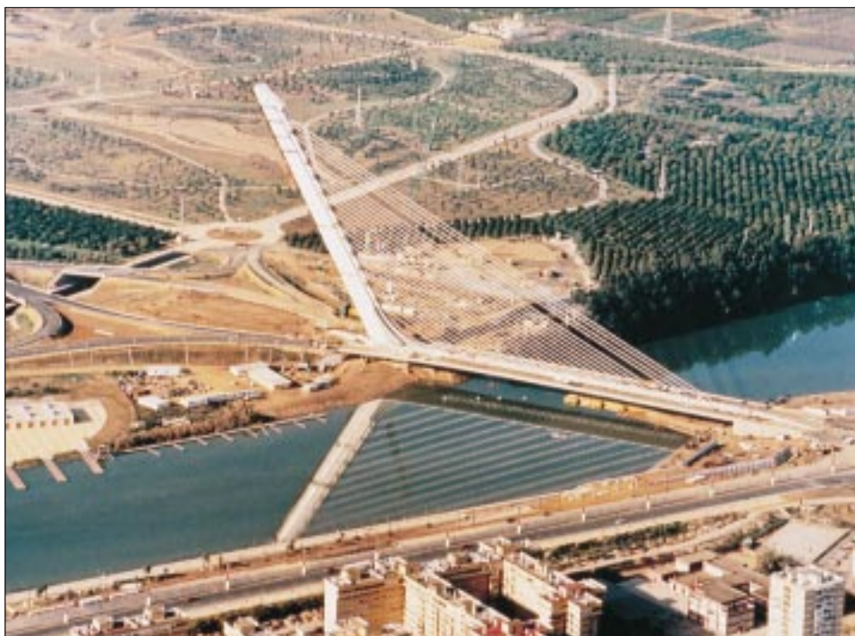
Puente del Alamillo, España
